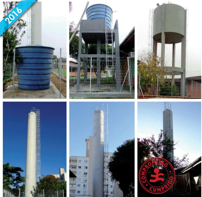
REFORMA HIDRÁULICA - A FCEE triplicou a reserva de água do campus. Hoje são mais de 119 mil litros de água distribuídos por toda FCEE, com três reservatórios de aço de carbono, um deles recuperado e outro ampliado a sua capacidade de 5mil para 10mil litros da água. Também foi reativado uma cisterna de 22 mil litros da água. O diferencial deste projeto foi a setorização de reservatórios permitindo eficiência na distribuição de água.
